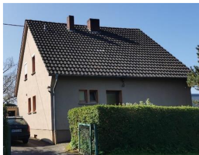
historisches Gebäude mit Putzfassade
