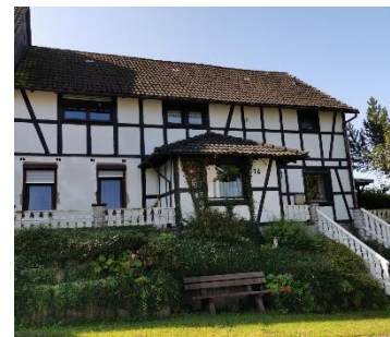
historisches Fachwerkgebäude mit Sanierungsbedarf
