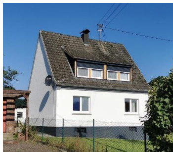
historisches Gebäude mit Putzfassade
