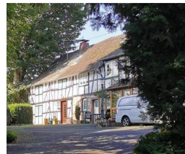
vorbildlich saniertes historisches Fachwerkgebäude, Kulturdenkmal
