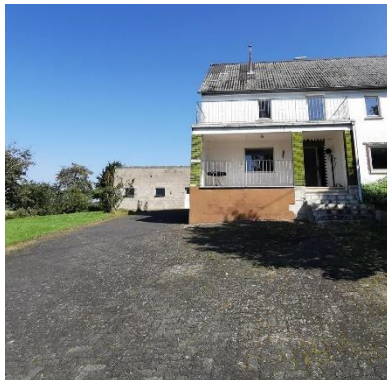
stark versiegelte Hoffläche ohne Begrünung
