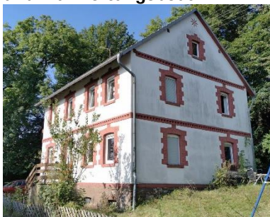
historisches Gebäude mit Sanierungsbedarf
