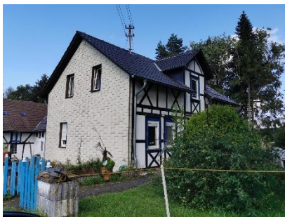
historisches Fachwerkgebäude mit Kunstschiefer-Verkleidung und Aufwertungsbedarf
